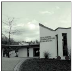
Gemeindezentrum im Hainbachtal Alte Talstraße 52
